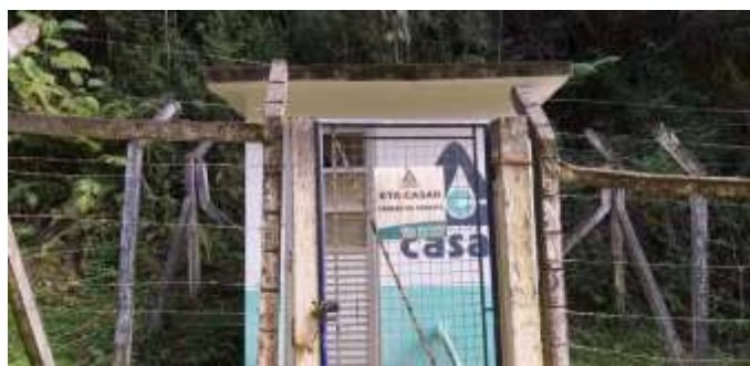
Figura 12: Câmara de Contato (cloração e fluoretação).
