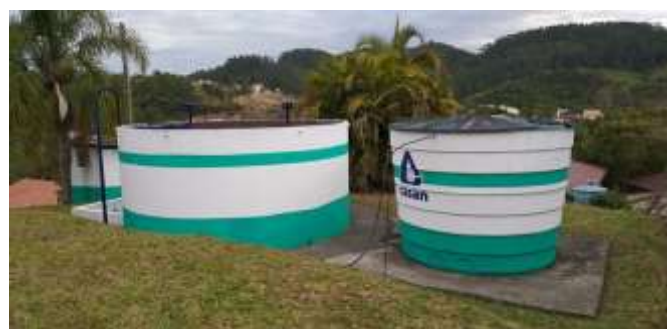
Figura 30: Reservatório R1 e R4.
