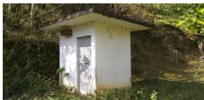
Figura 7: Abrigo do poço artesiano
