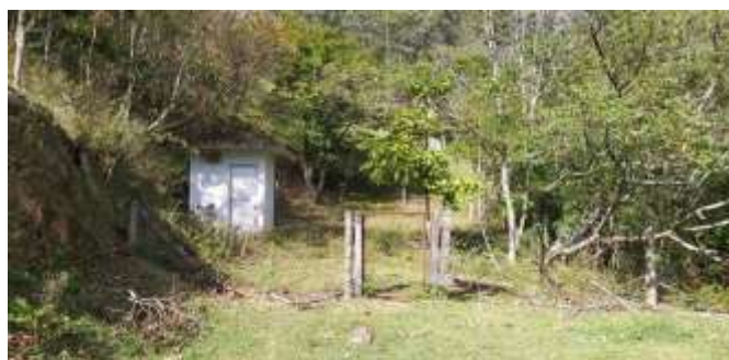
Figura 6: Abrigo do poço artesiano
