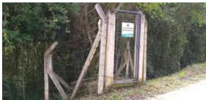
Figura 20: Caixa de Quebra de Pressão nº 2
