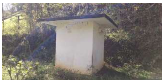
Figura 8: Abrigo do poço artesiano
