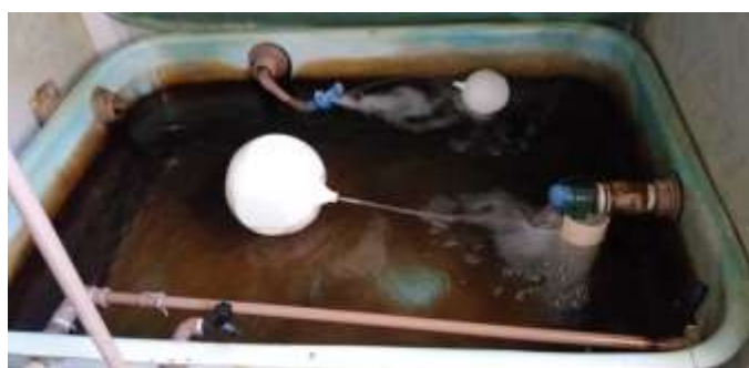
Figura 13: Câmara de Contato (cloração e fluoretação).
