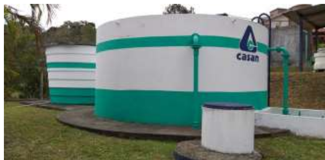
Figura 28:- Reservatórios R1 e R4.
