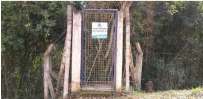
Figura 21: Caixa de Quebra de Pressão nº 2.
