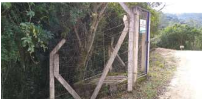
Figura 19: Caixa de Quebra de Pressão nº 2
