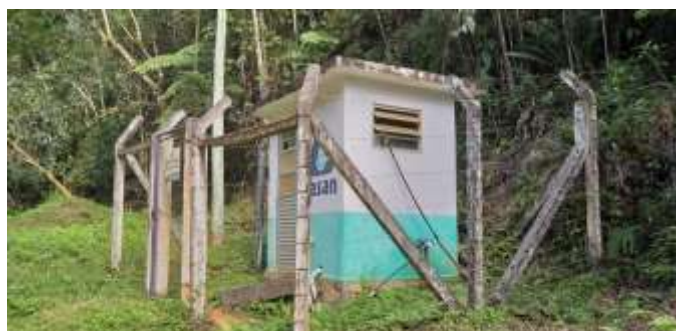
Figura 11: Câmara de Contato (cloração e fluoretação).
